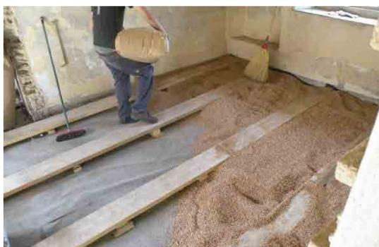
Gli spessori ed i formati del massetto a secco da utilizzare dipendono molto dall'interasse della struttura portante e dall'accessibilità dei locali.
