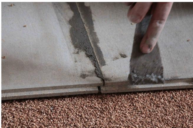
Per una corretta stuccatura ed incollaggio ci serviamo di prodotto specifici come **BetonElastic**, una malta cementizia che funziona sia per la stuccatura che per l'incollaggio riempiendo i giunti fra i pannelli.
