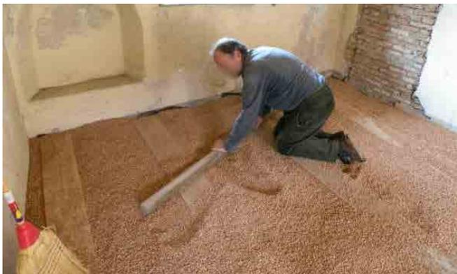
Dopo un'adeguata staggatura a secco del sughero in granuli, si possono fissare i pannelli in cementolegno **BetonWood** e bloccarli con delle viti passanti alla sottostruttura portante.
