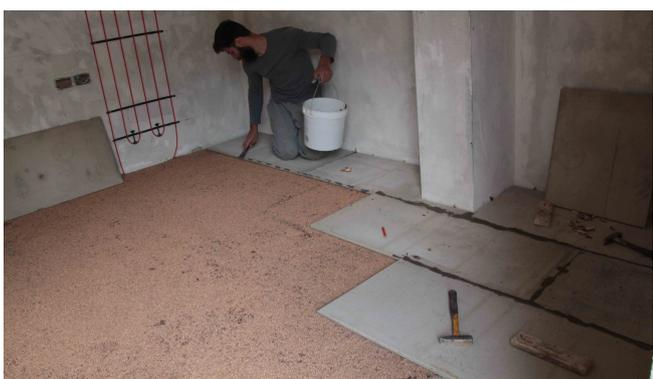
Esempio di pannelli in cementolegno **BetonWood TG** da ristrutturazione di piccolo formato: spessore 20 mm, formato 1200 x 500 mm, profilo ad incastro tongue&groove.
