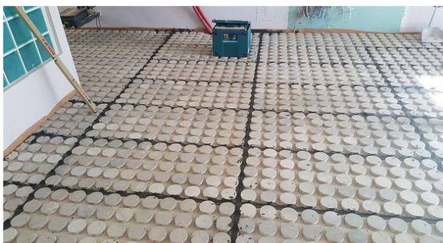
Verificare ulteriormente la planarità dei supporti ed il livello di bolla dei piani di futura pavimentazione.
