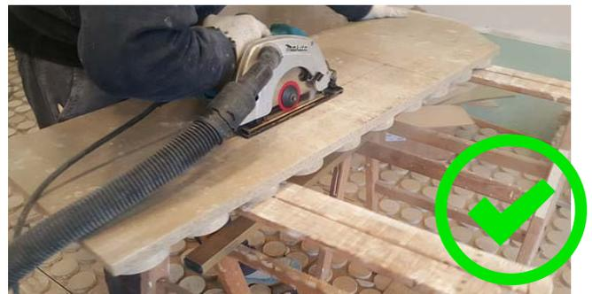
Si raccomanda di utilizzare strumenti idonei per effettuare il taglio dei pannelli radianti **BetonRadiant**. Sugeriamo di utilizzare seghe circolari, seghe da banco, gattucci, flessibili muniti di lame da legno al carburo o diamantate, ed impianti di aspirazione della polvere idonei.
