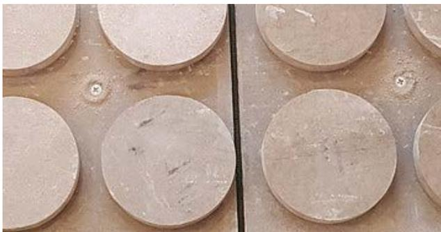
I pannelli **BetonRadiant** devono essere fissati agli strati sottostanti con 5 viti, 4 in corrispondenza degli angoli e 1 al centro del pannello.
