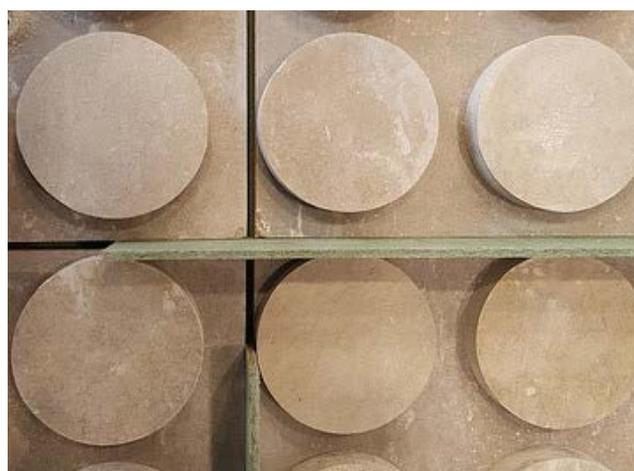
Durante la posa dei pannelli radianti **BetonRadiant** che devono rispettare uno spazio tra uno e l'altro per il giunto di dilatazione pari a 3 mm, si possono usare ritagli e scarti di tappetino in fibra di legno **FiberTherm Underfloor**.
