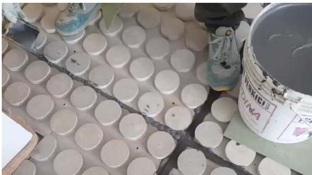
Adesso si può iniziare ad applicare nei giunti e nei bordi perimetrali la malta cementizia bicomponente elastica ed impermeabilizzante **Mapelastic** (Mapei) nelle fughe.
