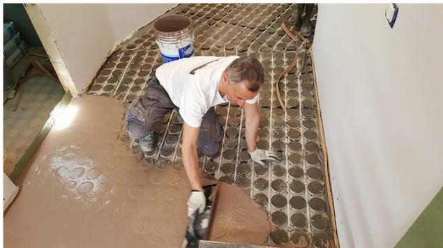
**Ultraplan Maxi** (Mapei) è una lisciatura autolivellante ad indurimento ultrarapido per spessori da 3 a 30 mm idonea quindi ad eseguire il livellamento ed il riempimento di sistemi radianti come il nostro.
